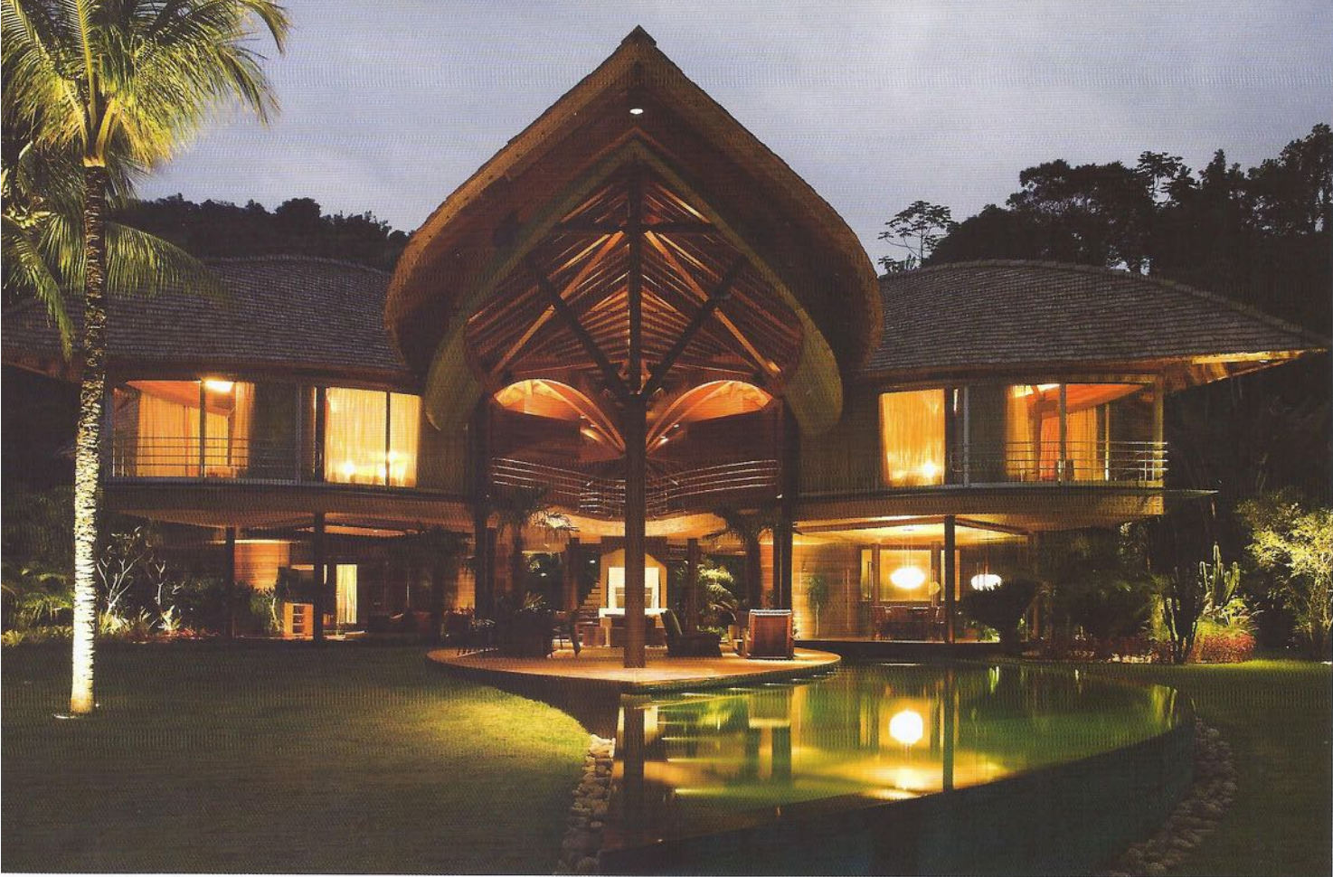
Varanda principal. Estrutura em madeira laminada de eucalipto. Arquitetos: Ivo Mareines e Rafael Patalano. Leonardo Finotti.
